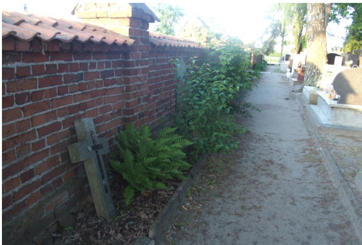
Widok od południowego-zachodu
