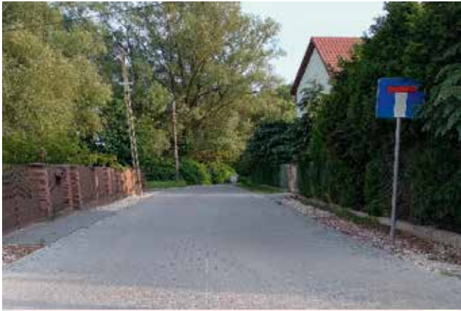
Budowa drogi wewnętrznej w miejscowości Stara Biała
