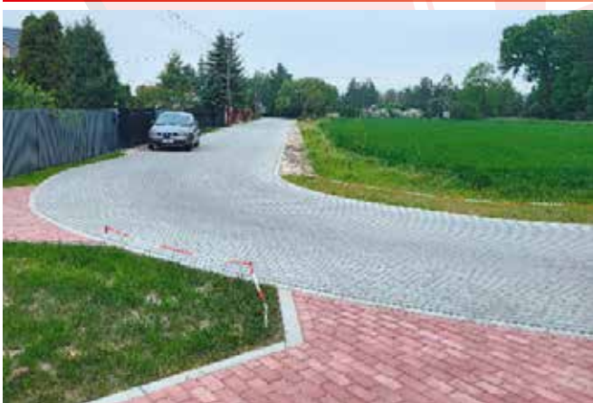
Przebudowa drogi wewnętrznej w miejscowości Mańkowo
