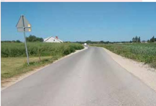
Budowa części drogi gminnej (ul. Bankowej) w miejscowości Biała
