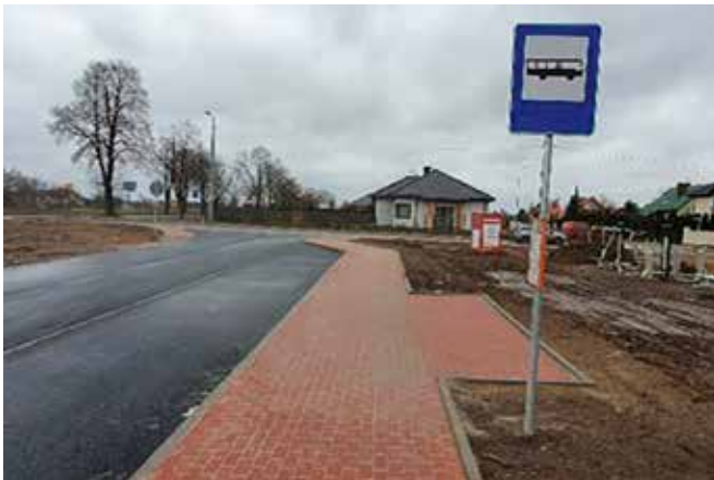
Budowa infrastruktury drogowej (pętla autobusowa) w miejscowości Mańkowo Wartość zadania: 320 254,07 zł
